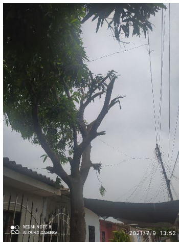
Figura 1. Árbol podado presuntamente por la señora Ana Milena Soto Ramírez, para evitar afectaciones a la infraestructura del servicio de energía eléctrica.
