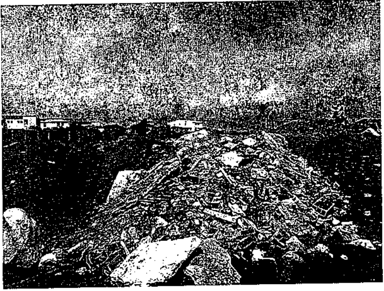
Foto No. 01 Fecha: 28- 04 - 2016 Lugar: 11° 1' 27''N - 74° 51' 57.9'' Observaciones: Disposición inadecuada de escombros.
