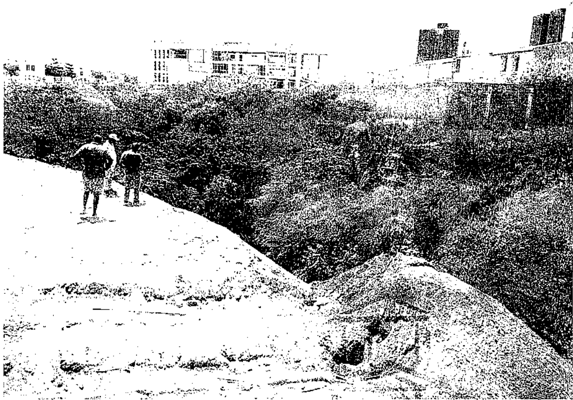
RELLENO DE CANAL DEL ANTIGUO ARROYO LA PLAYA
