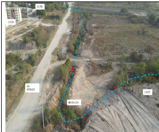
Imagen 3. Fotografía aérea en la que se evidencia el punto en el que se intervino el tubo de escorrentía y la afectación en el drenaje ubicado dentro del lote madero.
