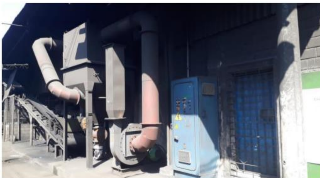
Foto 1 Instalación de extractor No. 1 Zona materias primas.
