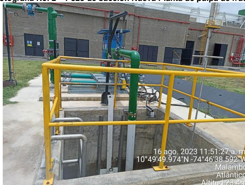
Fotografía No. 2 – Pozo de succión Nueva Planta de pulpa de frutas.
