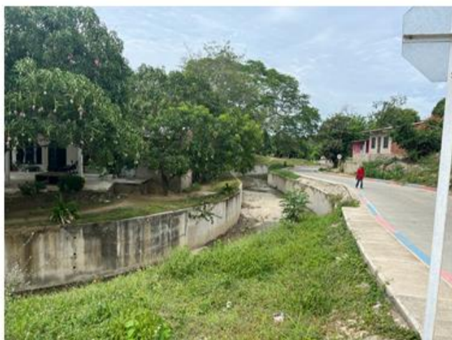
Foto N° 2 Fecha: 15 de mayo de 2023 Ubicación: canalización del arroyo El Cajón Observaciones: no se evidencia contaminación, si vegetación y material de sedimento debido al arrastre del arroyo
