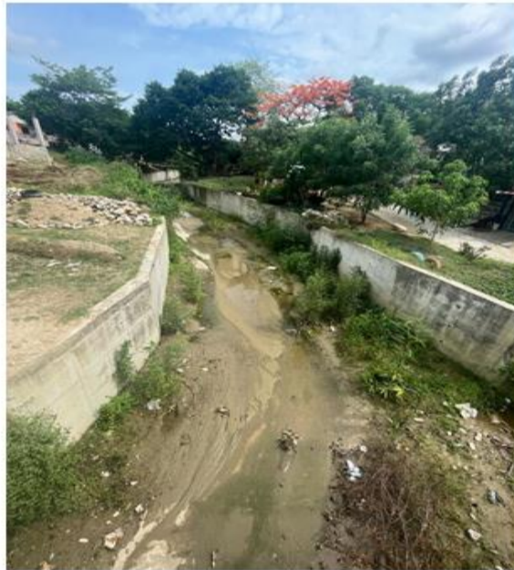
Foto N° 1 Fecha: 15 de mayo de 2023 Ubicación: canalización del arroyo El Cajón Observaciones: no se evidencia contaminación, si vegetación y material de sedimento debido al arrastre del arroyo
