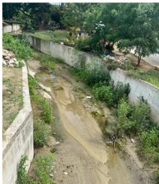
Foto N° 3 Fecha: 15 de mayo de 2023 Ubicación: canalización del arroyo El Cajón Observaciones: no se evidencia contaminación, si vegetación y material de sedimento debido al arrastre del arroyo
