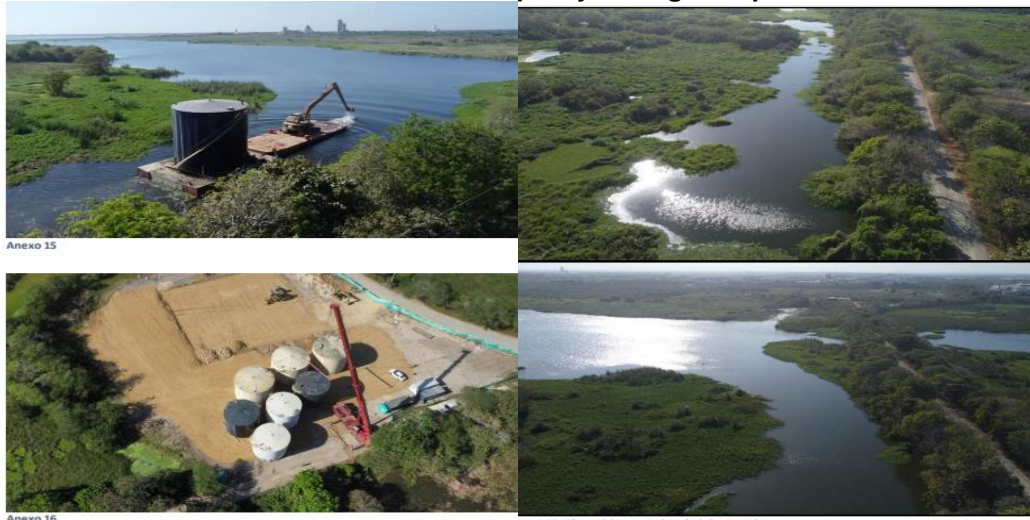
Ilustración 3 Instalación de los tanques y ciénaga después del traslado
