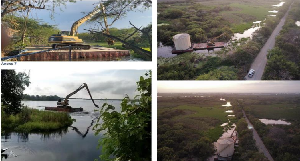
Ilustración 2 Movilización de los tanques a través de la barcaza
