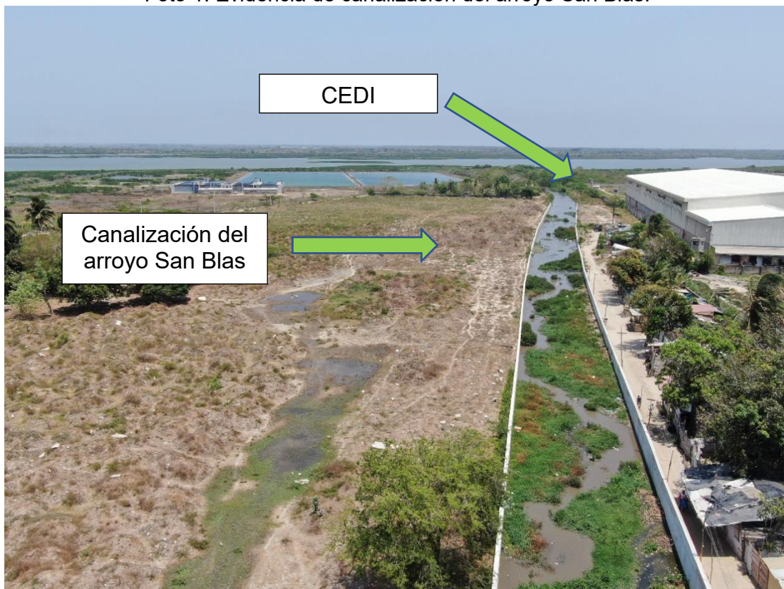
Foto 1. Evidencia de canalización del arroyo San Blas.
