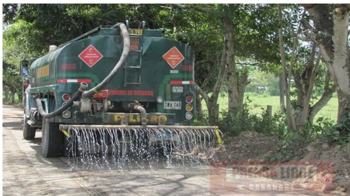
Fotografía No. 1 -Sistema de riego de vías
