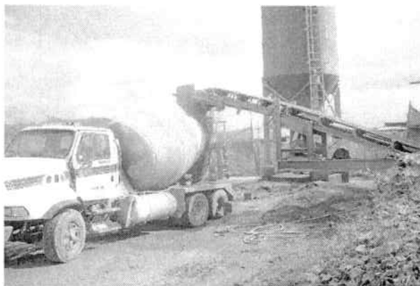
Foto No. 3- Cargue de los camiones o mixer.
