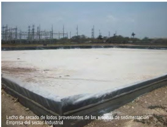
Lecho de secado de lodos provenientes de las piscinas de sedimentación Empresa del sector Industrial
