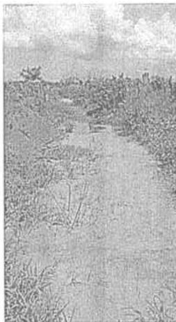
**Fotos 1 y 2.** Canal de drenaje de aguas lluvias donde se están descargando las aguas residuales ya tratadas del municipio de Manatí.
