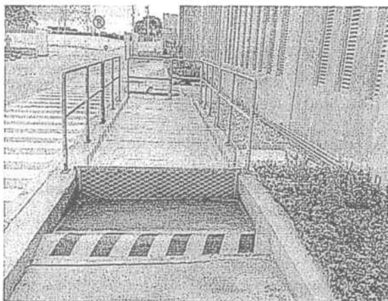
Fotografía No. 5 sistema de trampas de grasas para aguas oleosas (lavado de componentes)
