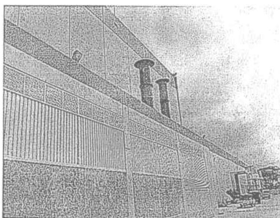
Fotografía No. 4 Chimeneas de descarga de emisiones tratadas en el lavador de gases.
