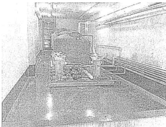
Fotografía No. 3 sistemas de tratamiento de aguas del lavador de gases con filtros para luego ser recirculada al proceso de lavado.
