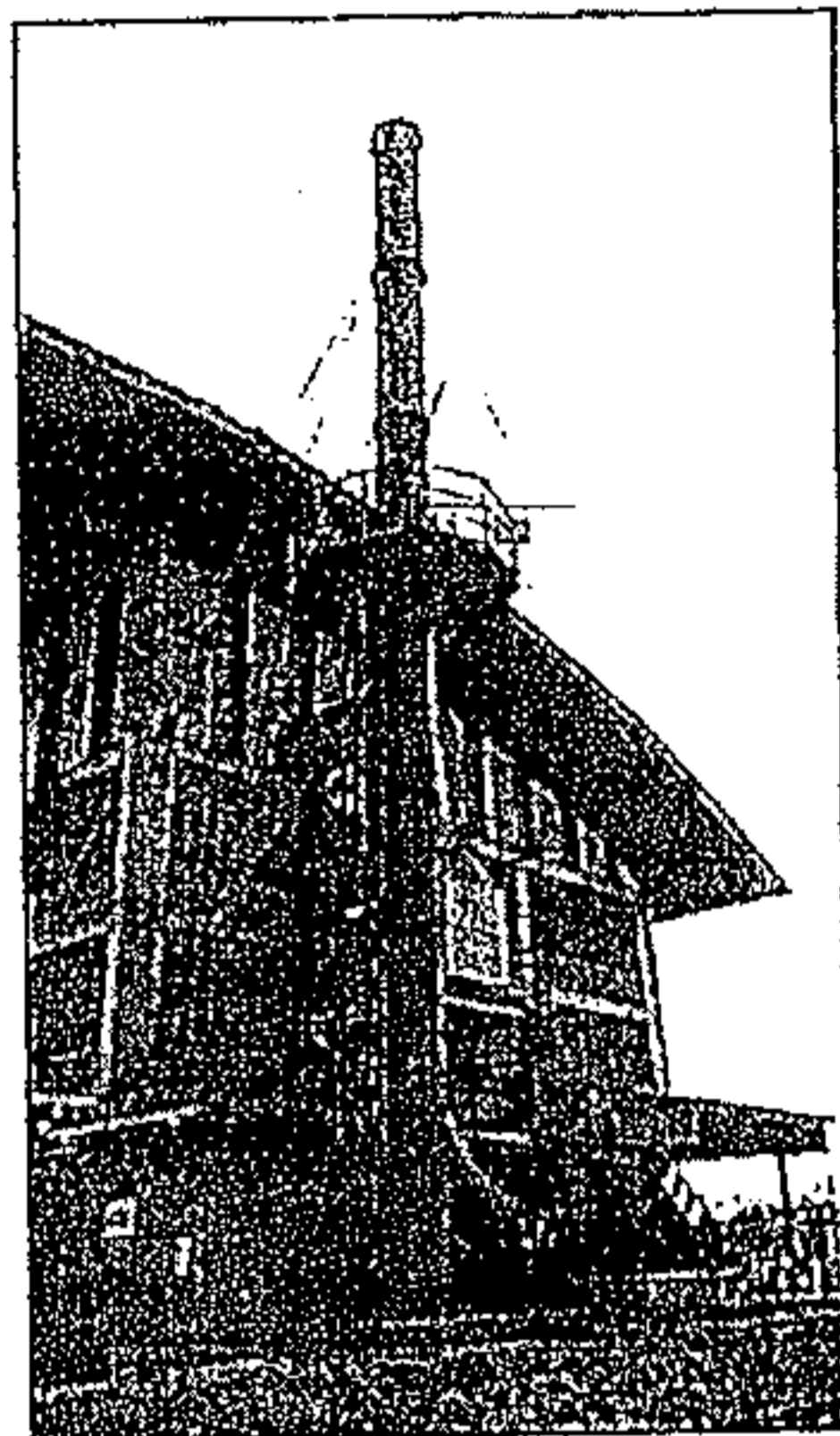
Figura 1. Chimenea de la empresa TECNIAMSA S.A. E.S.P con los puertos de toma de muestra, la plataforma de medición de las emisiones y los sistemas de control de emisiones. Fuente: información aportada por la empresa.
