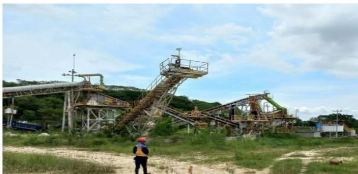
Figura 2. Vista general de la Planta de agregados
