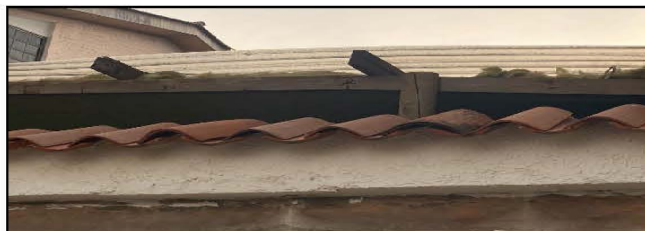
Fotos No.3 y 4 Material de freskasa entre techo y tejas en paredilla lateral del establecimiento TROPIQUE FOOD CLUB S.A.S
