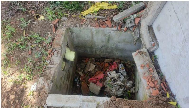
Foto 5. Tramo superior del sistema de alcantarillado que recibirá las ARD del colegio.
