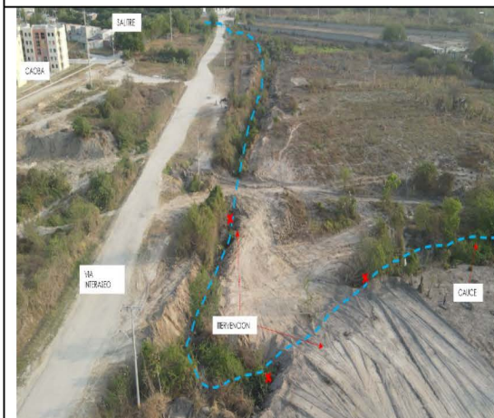
Imagen 3. Fotografía aérea en la que se evidencia el punto en el que se intervino el tubo de escorrentía y la afectación en el drenaje ubicado dentro del lote madero.
