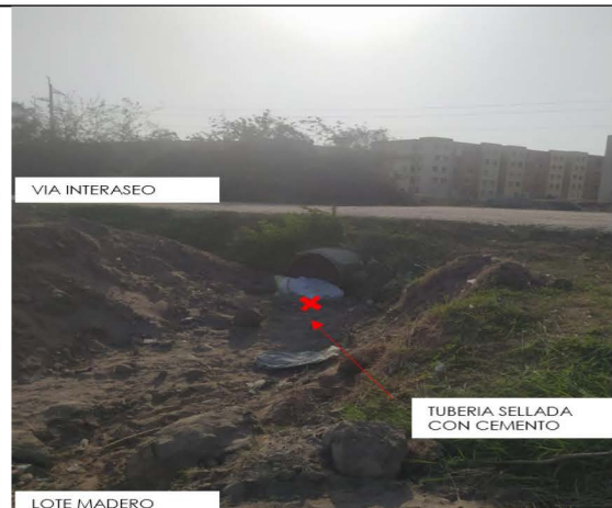
Imagen 2. Fotografía aérea en la que se observa la intervención en el tubo de escorrentía que se encuentra en el lote madero.
