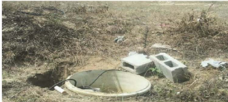
Imagen 1 Aspecto del pozo, fuente: Expediente CRA 501-435
