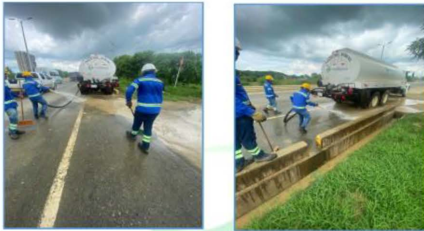
Ilustración 7 Barrido y lavado del área que comprende la intersección entre la vía Al Mar con la cantera “Casa Blanca”
