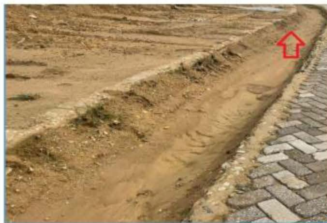
Ilustración 5 Limpieza de cunetas y canales perimetrales
