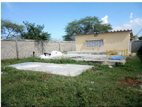
Foto 3. Acceso a EBAR Santo Tomás
