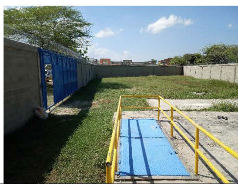
Foto 3. Acceso a EBAR Santo Tomás
