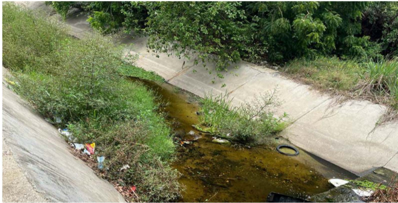
Foto N.º 1 Fecha: 11 de junio de 2023 Ubicación: Caño Fistula en Sabanagrande- Atlántico. Observaciones: Canalización finalizada.
