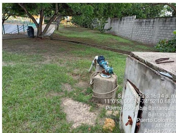
**Fotografía No. 1 - Pozo para captar aguas subterráneas, con su medidor de caudal**
