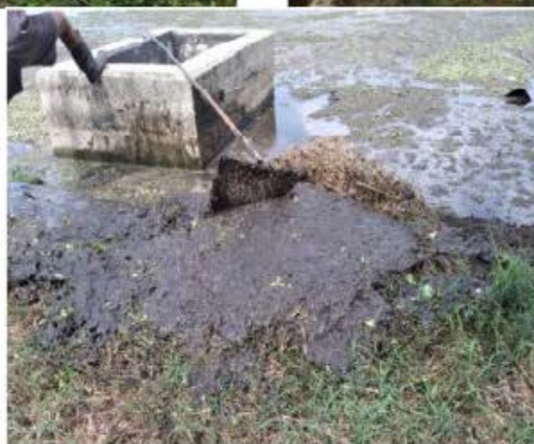
Estado final después del mantenimiento a los sistemas:
