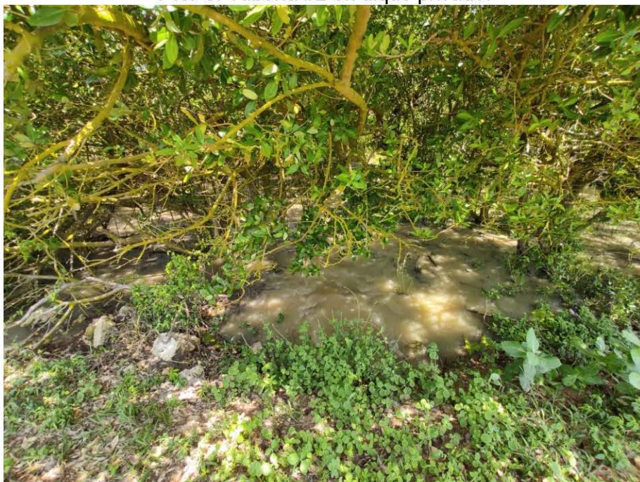
Foto 9. Tubería #2 en dique privado.
