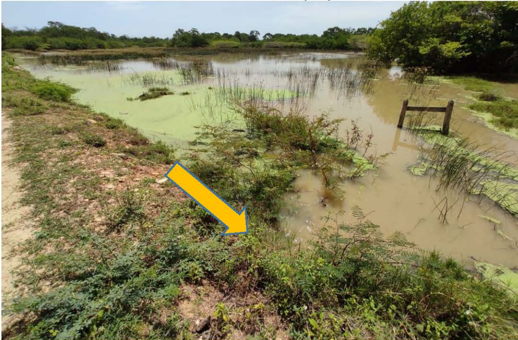
Foto 8. Tubería #1 en dique privado.
